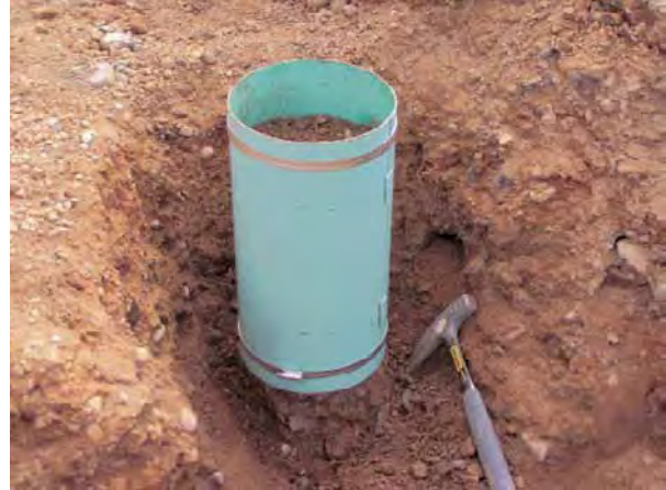
Photo.7 既設堤体部 B からの大型コア供試体の採取状況 Sampling of undisturbed large-size specimen from zone B
