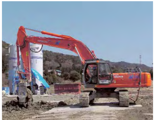
Photo.3 底泥土の初期固化状況 (トレンチャー式攪拌混合機)
