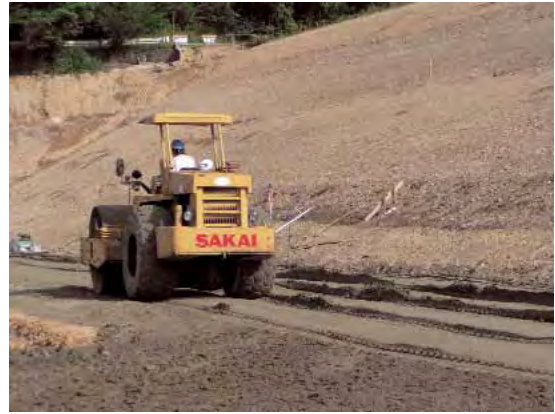
Photo.6 振動ローラによる転圧状況 Compacting by vibratory compacting roller
