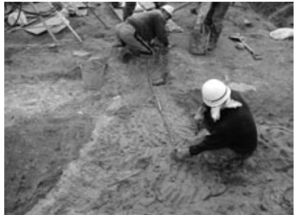
Photo 4-5 基礎地盤面への電極設置状況
