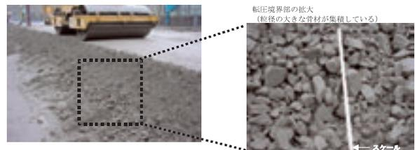
Photo 3-7 RCD コンクリート転圧時の施工状況
