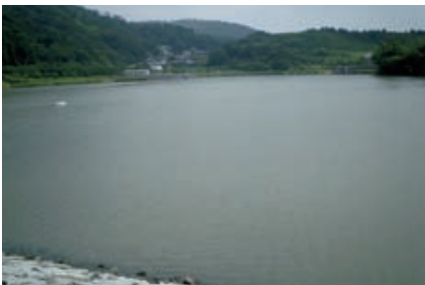
Fig.15 対象とした南椎尾調整池
