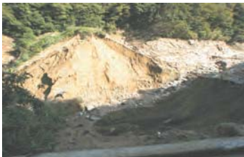
(c) 堤体越流により決壊したため池
