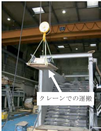
Fig. 186 クレーンで土嚢を運搬している様子 Transportation of soil bag by crane
