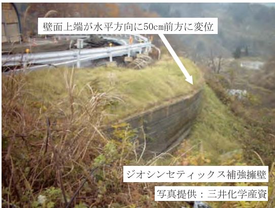
(c) 県道 (山古志村, 擁壁高H=4.2 m, 1V: 0.1H)
