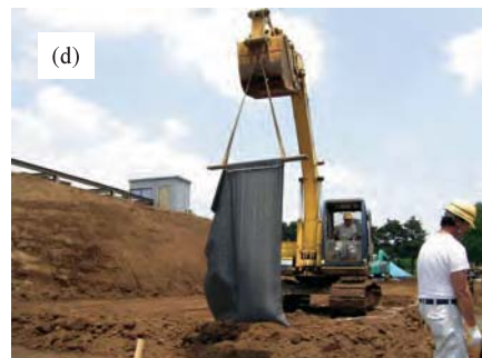
Fig. 261 中詰め材充填用型枠を用いた土嚢の作成方法 : (a) バックホウを用いて関東ロームを土嚢袋に投入している状況 ; (b) 拡大図 ; (c) 運搬用吊り具を取り付けた土嚢 ; および (d) 土嚢の運搬状況
