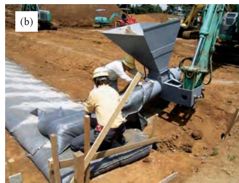
Fig. 260 中詰め材投入機を用いた土嚢の作成方法 : (a) 中詰め材投入装置をバックホウに取り付けた様子 ; (b) 再生砕石を土嚢袋に投入している状況
