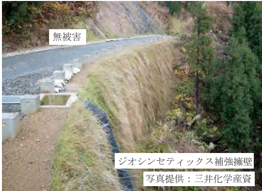
(b) 林道(北魚沼郡, 擁壁高H=4.9 m, 1V: 0.3H)
