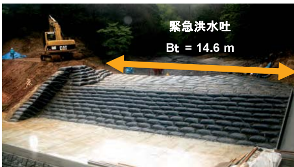
(a) 土嚢積層システム構築後の状況
