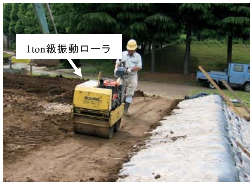
(a) 土嚢背面の締固め状況
