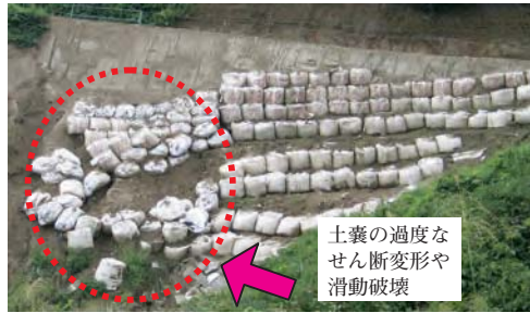
(a) 道路法面の応急復旧事例 (2004年新潟県中越地震)
