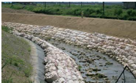
(c) 河川堤防の応急復旧事例 (2004年新潟県中越地震)
