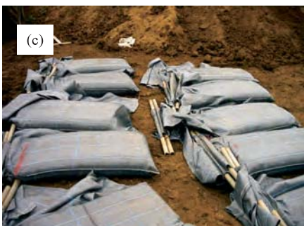
Fig. 261 中詰め材充填用型枠を用いた土嚢の作成方法 : (a) バックホウを用いて関東ロームを土嚢袋に投入している状況 ; (b) 拡大図 ; (c) 運搬用吊り具を取り付けた土嚢 ; および (d) 土嚢の運搬状況
