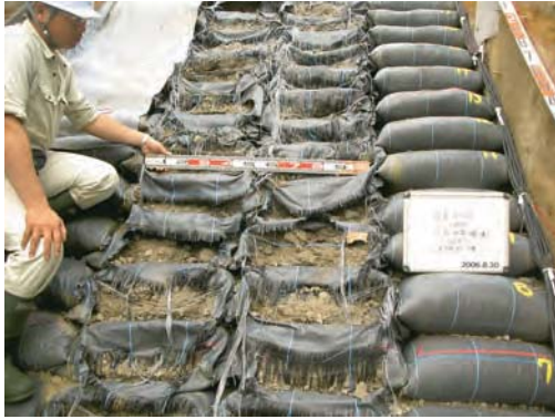
Fig. 237 人工的損傷を与えた条件での越水後の堤体下流斜面の侵食状況
