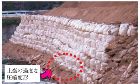
(b) 道路の斜面崩壊の応急復旧事例 (2004年台風23号,淡路島)
