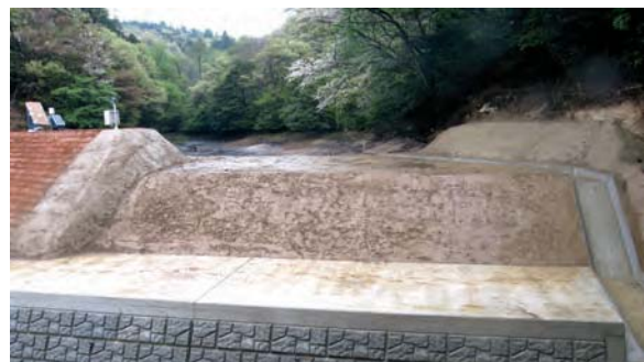
(b) ソイルセメントにより覆土処理した状況
