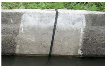
補修された継目
