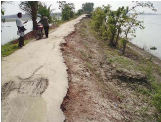
写真1 毎年洪水により繰り返しの波浪侵食を受けている農村道路
