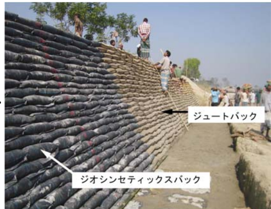
写真2 土嚢工法を適用した道路盛土の波浪侵食対策
