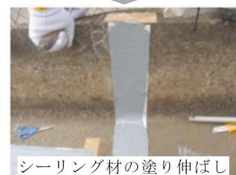
写真2 シーリング材による
