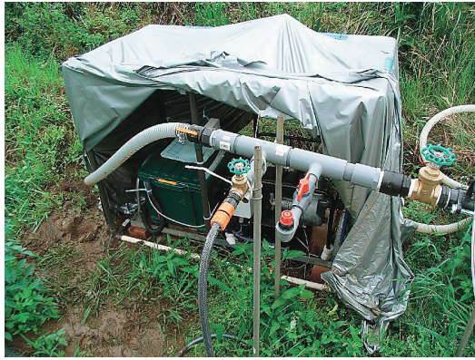
写真3. かん水・施肥システムの設置状況
