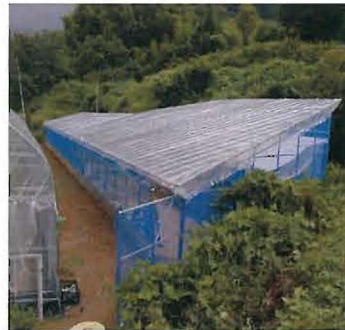
棚田に建設された平張型傾斜ハウスと湧水を利用した低コストの育苗装置
