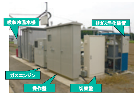
トリジェネレーションシステム
