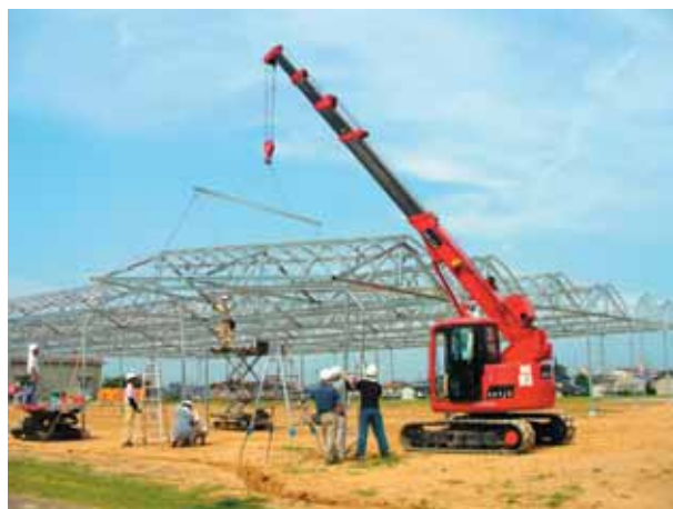
図3 屋根ユニットのクレーンつり上げ (天窗部材はすでに取り付けられている)
