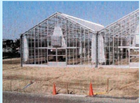
写真1：建設当時の高軒高ハウス
