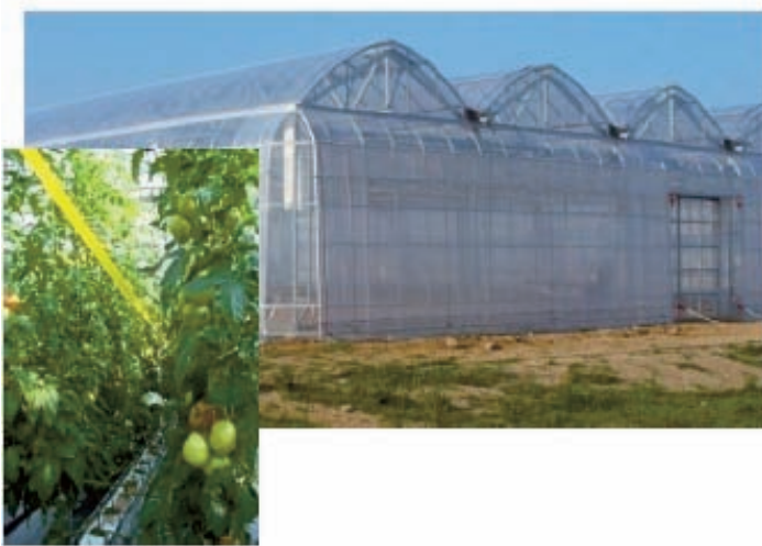
図-1 新部材・新工法による「超低コスト高軒高大型ハウス」
