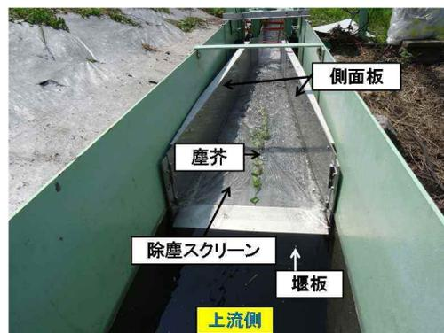
図2 農業用水路に設置した除塵装置
