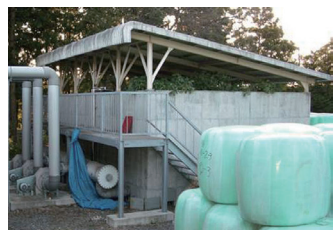
図1 畜産草地研究所のロックウール生物脱臭装置の外観
