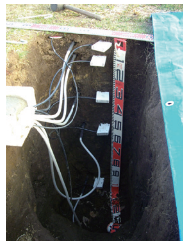
Fig.5 地中観測ピットへの機器埋設状況
