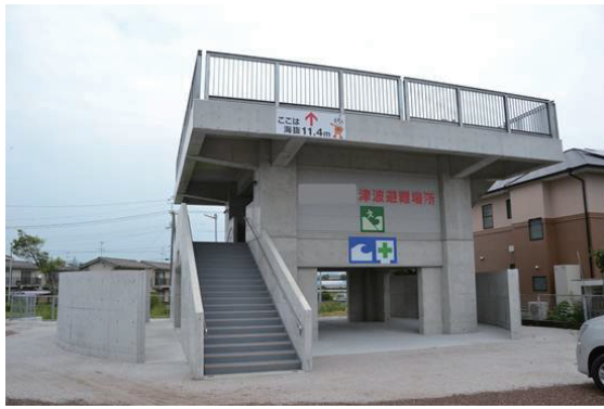
Fig.4 農業地域における津波避難タワーの例 A tsunami refuge tower in an agricultural area
