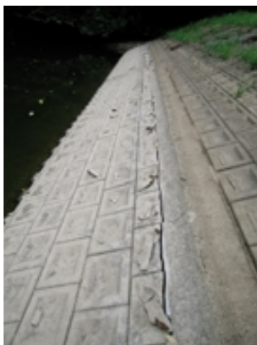
Fig.33 保護ブロックの損傷（本村大池） Damage to concrete block surface on an upstream slope
