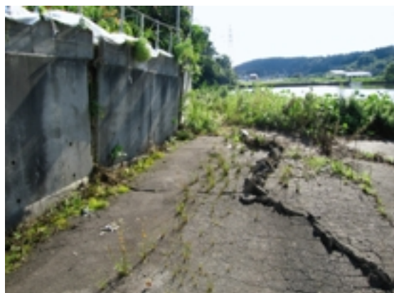
Fig.25 池上流の護岸部の亀裂（鬼王池） Crack failure of foundation behind sheet pile wall
