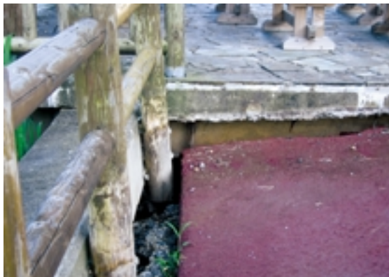
Fig.30 遊歩道の沈下と護岸の変形（長峰大池） Damage of seawall and road
