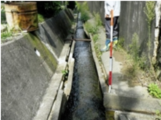
Fig.47 変形したベンチフリュームの側壁 Deformation of a sidewall bench flume
