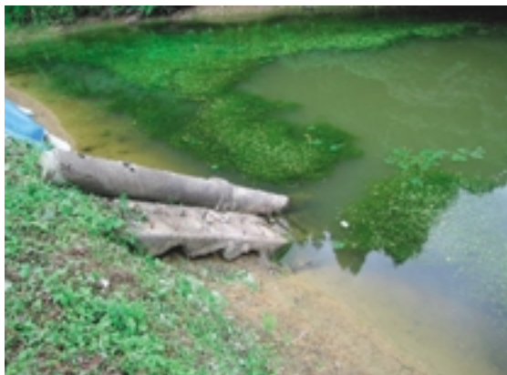
Fig.12 斜樋の状況（入山溜）
