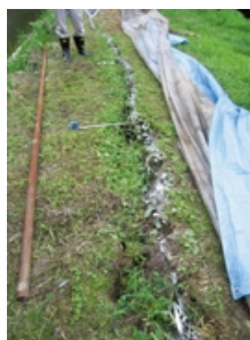
Fig.36 天端の亀裂（柳沢新池） Open crack on top of dike
