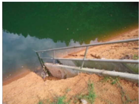
Fig.19 斜樋脇のすべり (2007 年 8 月 7 日) Slip failure of the slope at the inlet work
