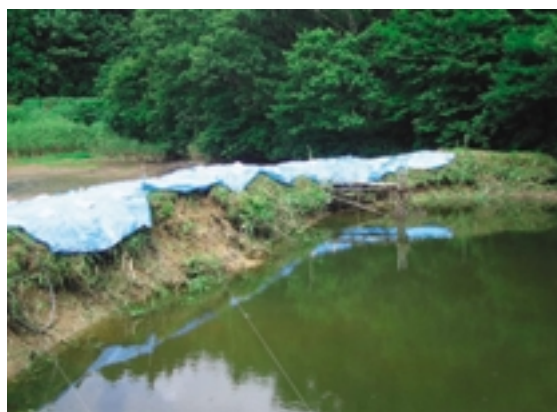
Fig.17 上流法面のすべり（三十刈池） Slip failure on upstream slope
