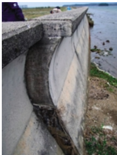
Fig.5 波消しブロックの変位（外地区） Inclining of Seawall
