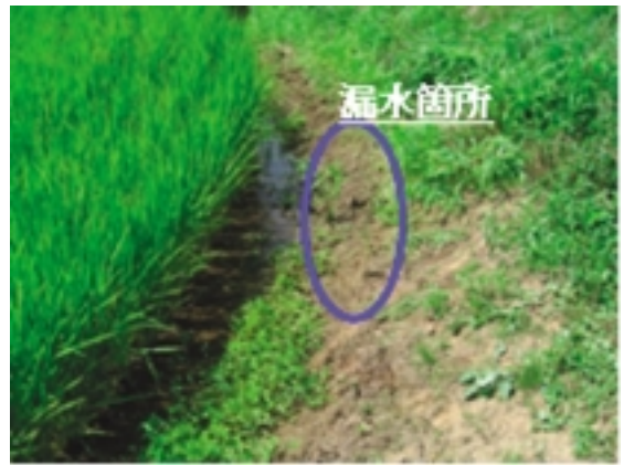
Fig. 42 水路堤防右岸側法尻部（断面 A）からの漏水 Seepage at the toe of a canal bank (section A)
