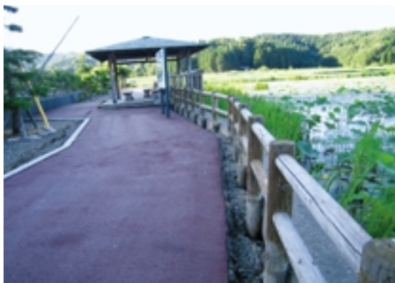
Fig.29 遊歩道の沈下（長峰大池） Settlement of circle road
