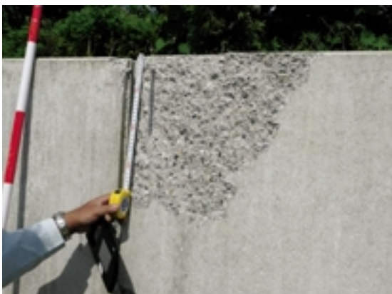
Fig.12 L型水路におけるコンクリートの剥落 Stripping of concrete in L-type canal
