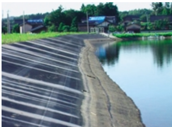
Fig.21 ゴムシートのズレ (斜面の変形, 大池) Deformation of upstream slope and sheet
