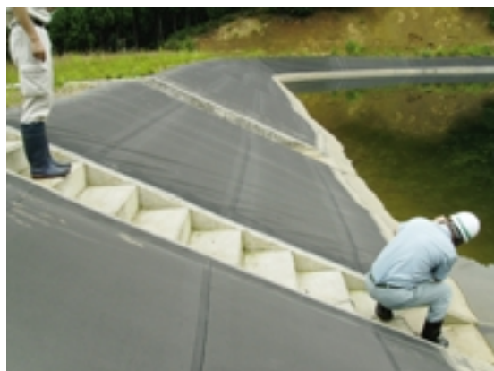
Fig.52 表面遮水シートに生じた皺（大堤） Wrinkles in geomembranes
