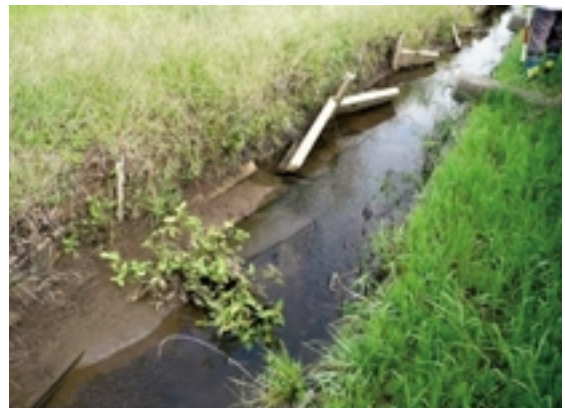
Fig.33 コンクリート柵渠における柵板の崩落 Breakage and collapse of fence boards of a drainage canal
