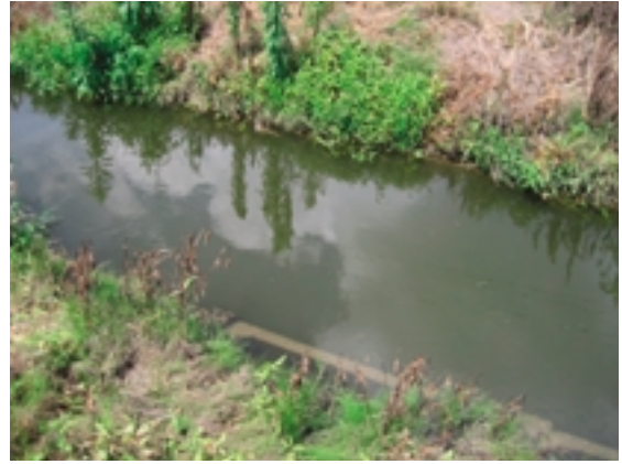
Fig. 41 沈下部における通水時の状況 Water flowing over a submerged section of a canal
