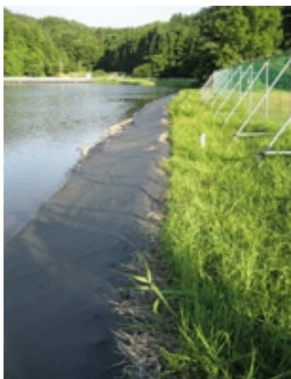
Fig.50 表面遮水シートの被害（松ヶ崎池） Damaged geomembranes
