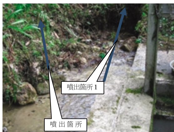
Fig.10 下流法先での漏水状況（堂めき池） Piping hole at the toe end of the slope
