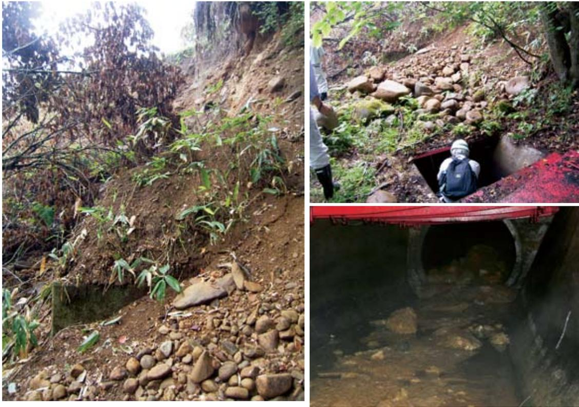
**Fig.10** 大原堰用水路下流トンネル出口の崩落状況（左，手前コンクリートは出口補強部），
