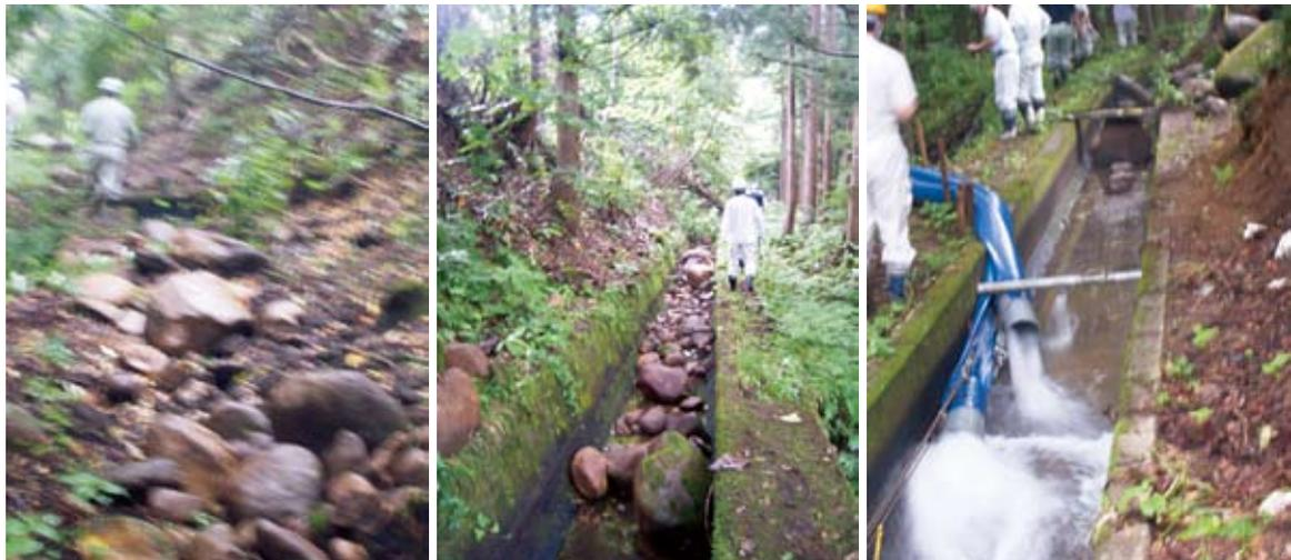
**Fig.11** 大原堰用水路の開水路グレーティング上への落石状況（左），開水路への落石状況（中），
