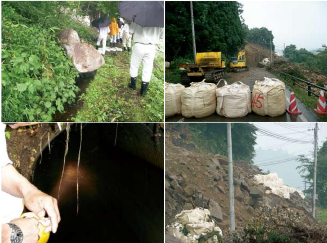
**Fig.14** 下真坂用水1号トンネルの被災 (左上：トンネル上流開水路への転石 (Fig.12, ①地点), 左下：トンネル出口付近の堆積土 (Fig.12, ③地点), 右：トンネル上部の斜面崩壊 (Fig.12, ②地点)
