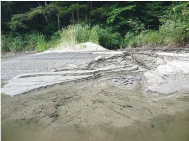
Fig.12 ため池流入部の底質の浸食状況 (9月11日)
