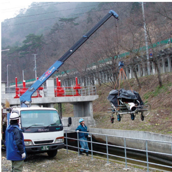
Fig. 5 装置の搬入状況
