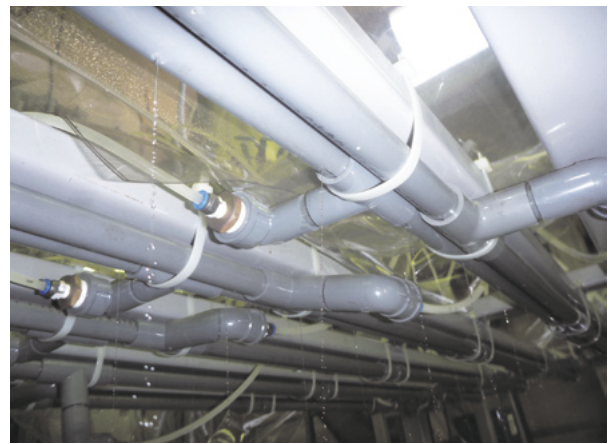
Fig. 6 降水発生状況
