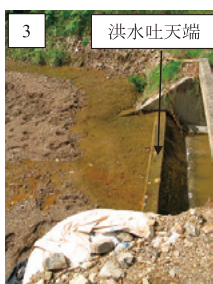
Fig. 14 ③池の洪水吐天端まで達した土砂 Sand and mud above spillway of ③ ike
