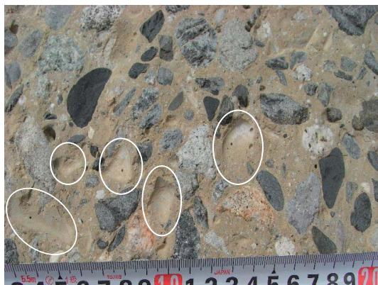
**Fig. 26** 摩耗表面の拡大
