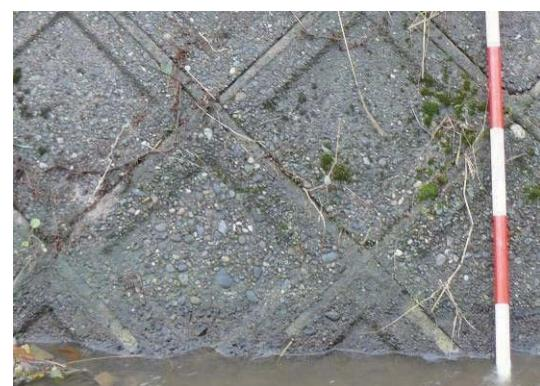
**Fig. 57** 現地水路ブロックの摩耗状況
