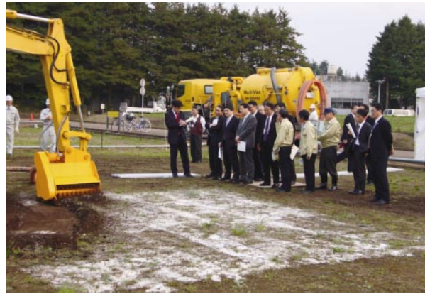
固化剤を用いた表土削り取り工法による除染作業の視察状況
