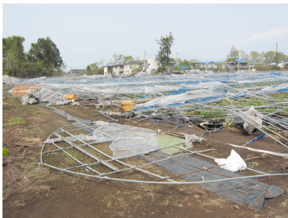
写真1 竜巻によって被災したパイプハウス
