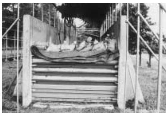
写真 26 搬入口と取り出し口に設置した仕切り板
