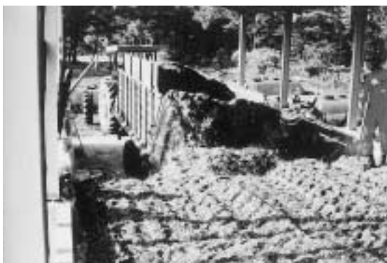
写真6 バンカーサイロにおける材料の詰め込み作業 Photo 6 Forage loading work in bunker silo
