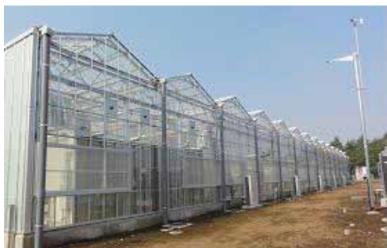
農研機構(NARO)つくば実証拠点施設の外観
