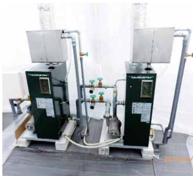
図2 クラウン加温用熱交換パイプの敷設状況(上、矢印で示した部分)と加温用ボイラ(下)
