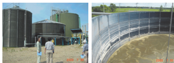
図2 北海道別海町で稼働しているバイオガスプラント 左の写真のもっとも背の高い右タンクが発酵槽、左となりにメタンガスを蓄積するタンクが見える。 右の写真は発酵後の液が貯留されている様子を示す。発酵液は現在肥料としての利用が検討されている。
