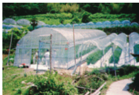
図1 傾斜面に建てられた簡易雨よけ(右)と市販の鉄骨補強アーチ型パイプハウス(左)
