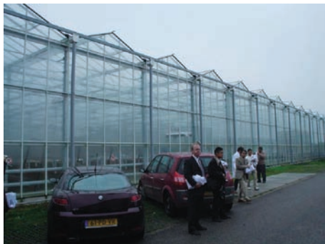
図 2 軒高が 5 m のオランダの温室
