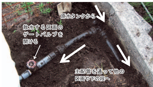
写真3 圃場を区切るゲートバルブ
