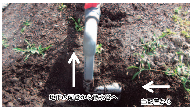
写真4 地下配管からの立ち上がり
