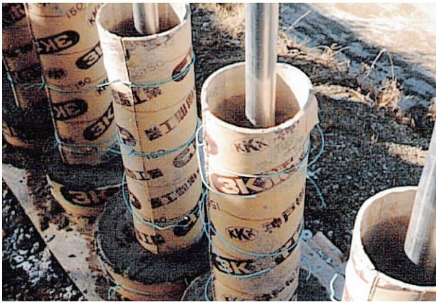
写真5 ベース付基礎作りの様子
