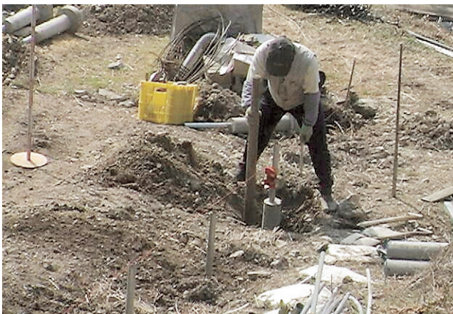
写真7 ベース付基礎の埋設作業
