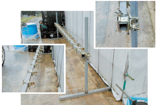
写真4 試作した移動可能な架台
