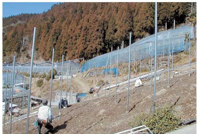
写真8 傾斜地での支柱設置作業
