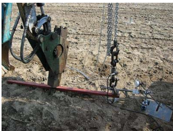
(e) 回転止め金具の固定状況
