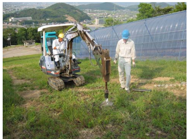
写真9 傾斜18° 圃場での施工
