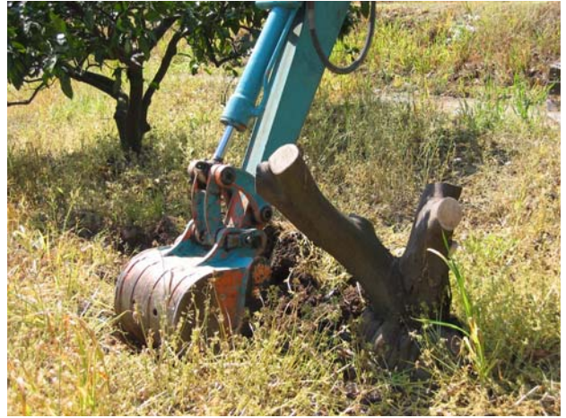
第2図 土掘削用バケットでの作業
