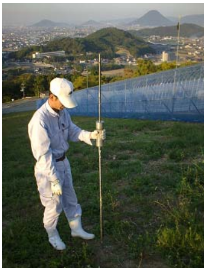
写真6 簡易動的コーン貫入試験
