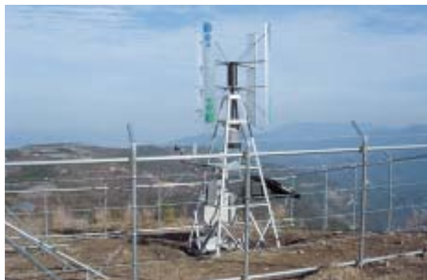
写真3 イチゴのハウス団地を背にしたハイブリッド発電装置
