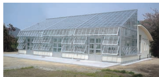
果樹環境制御実験棟全景（施設南側）
