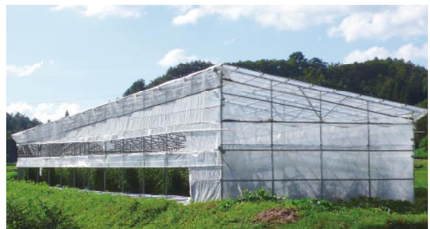
写真2 農家が施工した両屋根型のハウス（広島県北広島町西八幡原）
