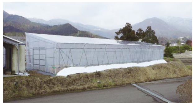
写真3 片屋根型のハウスの冬の状況（愛媛県久万高原町JA松山市久万育苗センター）
