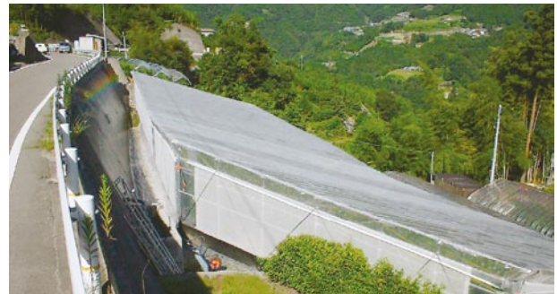
写真1 傾斜20度に建てた平張型傾斜ハウス（徳島県東みよし町加茂山）
