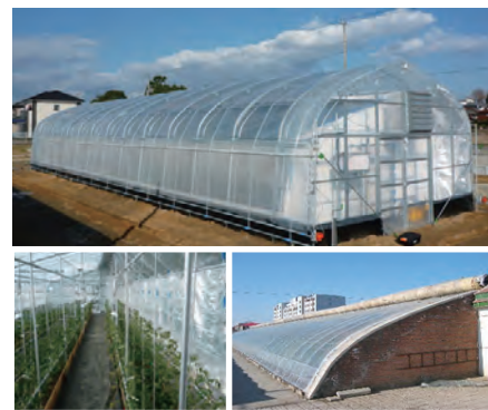
図2 開発中の日本型日光温室（上）とその内部（左下）および中国の日光温室（右下）
