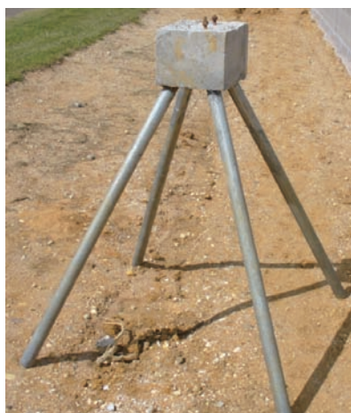
図1 パイプ斜杭打込み基礎
