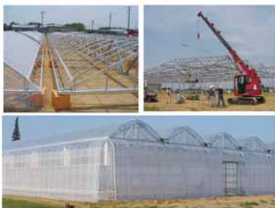
図2 屋根ユニットのクレーン吊り上げと完成ハウスの外観（972㎡）
