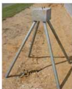
図1 パイプ斜杭打ち込み基礎
