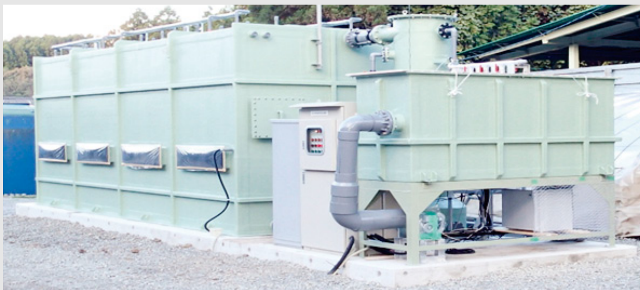
微生物環境制御型脱臭システム
