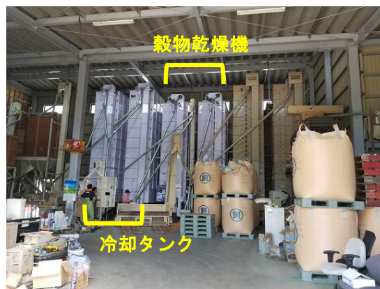
図 7-2-4 穀物乾燥機と冷却タンク
