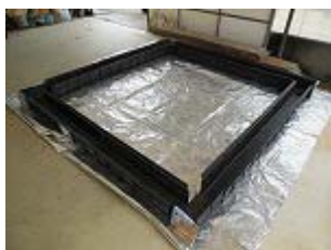
① 水封枠の設置
