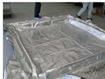
③ 水封枠にベースシート挿入
