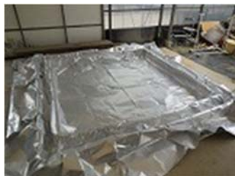
② ベースシートの設置
