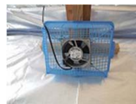
⑥ ガス攪拌ファンの 設置
