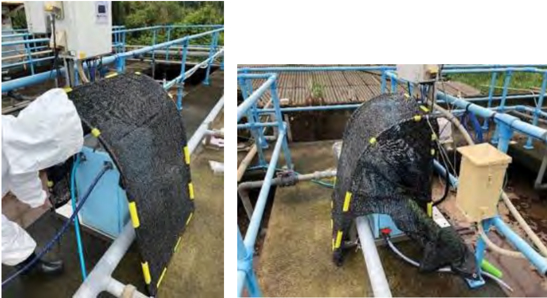
図 7-6 遮熱対策の外観
