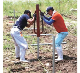
単管を約50cm打ち込みます
