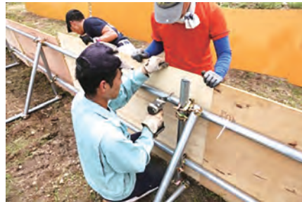
・ドリルで穴を開け、耐候性タイラップなどでコンパネを固定します
