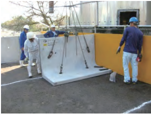
クレーン作業
