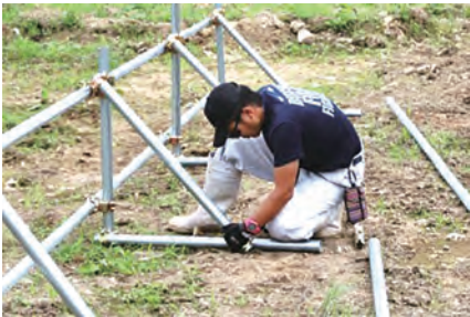
・支柱はクランプで三角形に固定し、横梁を上下2本入れます。
