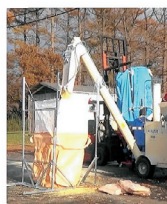
破碎機をストップして、満杯フレコンを交換
