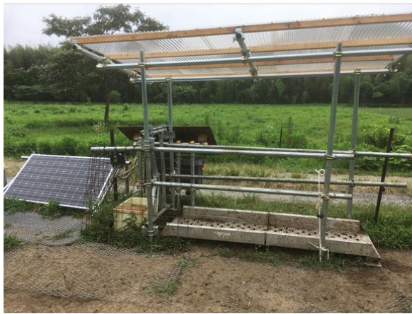
1) 単管パイプと鋼線メッシュの事例 (栃木県S牧場)
