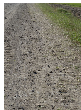
除泥装置あり
