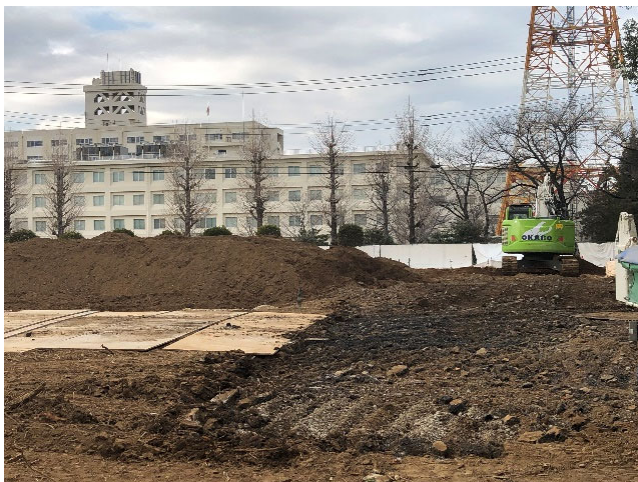
平成 31 年 2 月 北宿舎跡地工事
