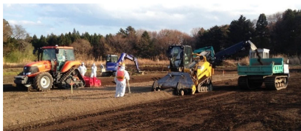
(2013年12月6日、大熊町大河原地区ほ場) 図4 表土削り取り作業実証試験
