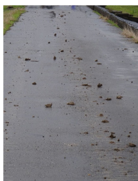
除泥装置あり
