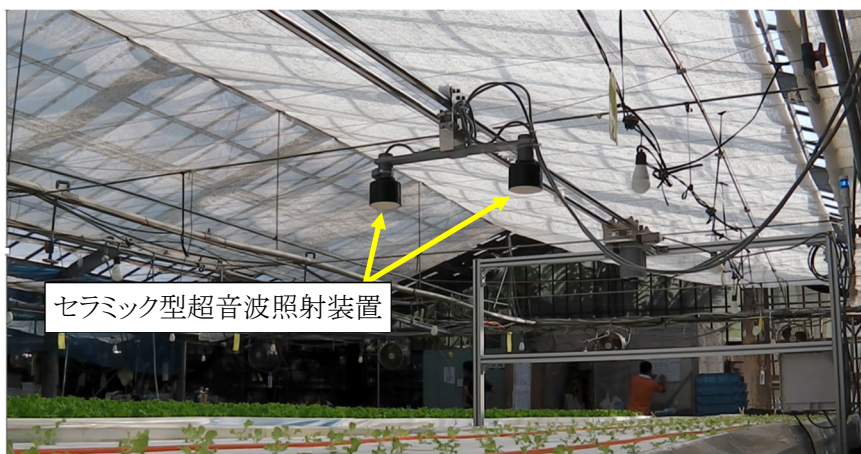
図 2-2 広範囲に超音波を照射可能な可動式の超音波照射装置
