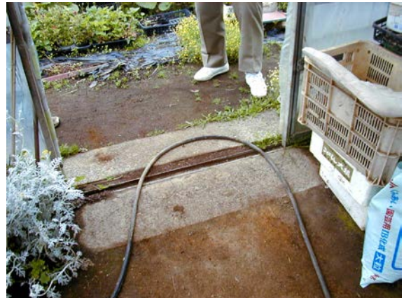
作目：野菜 作業：圃場・施設整備、運搬 目的：施設整備 方法：ハウスの引き戸レール保護のため、コンクリート板を前後に敷いた。段差のないように設置。
