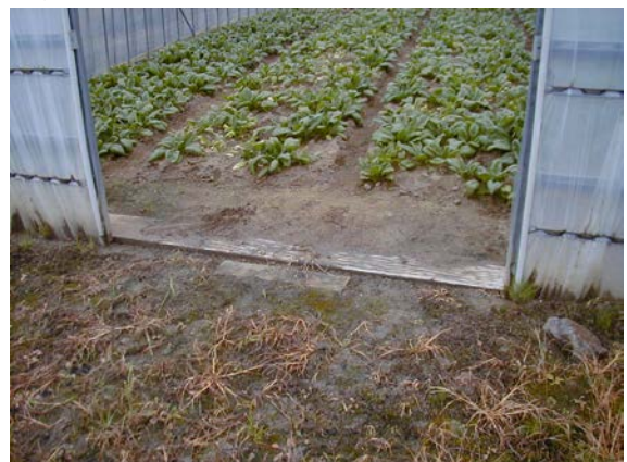
作目：野菜 作業：運搬、圃場・施設整備 目的：施設整備 方法：ハウスの引き戸の敷居を取り外し、板を前後に敷いた。段差のないように設置。
