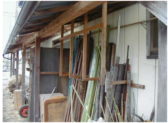
作目：共通 作業：圃場・施設管理 目的：施設整備 方法：杭、支柱等の収納枠を設置。
