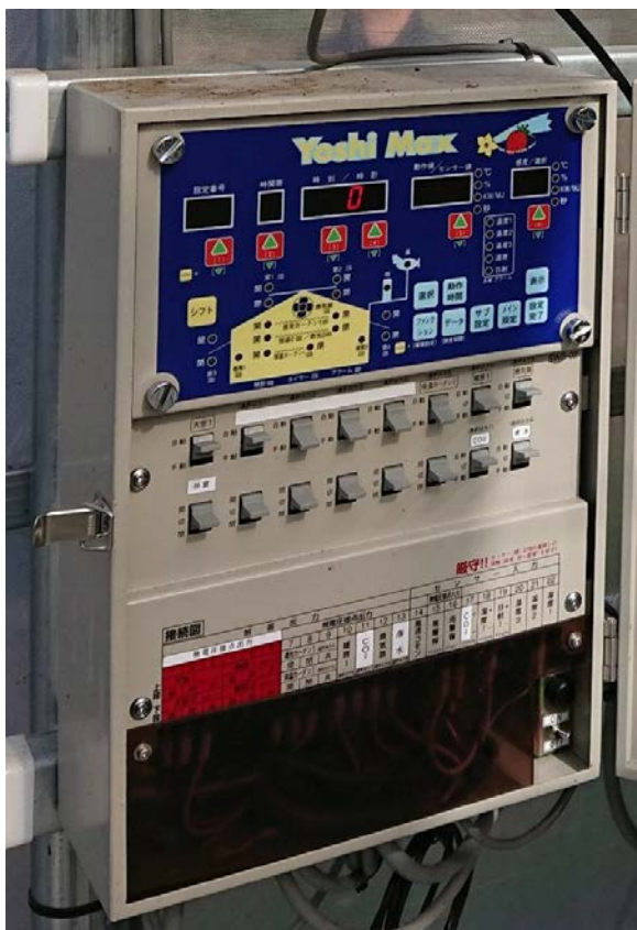
制御機部 (制御盤)
