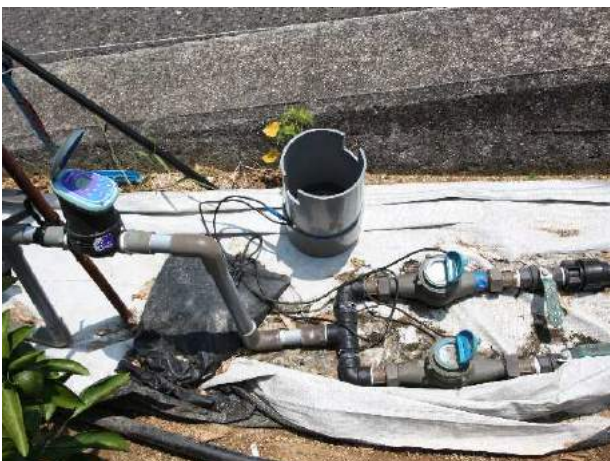
写真VI-3-5 園地との接続部分 注：水や液肥は、右から左へ流れている
