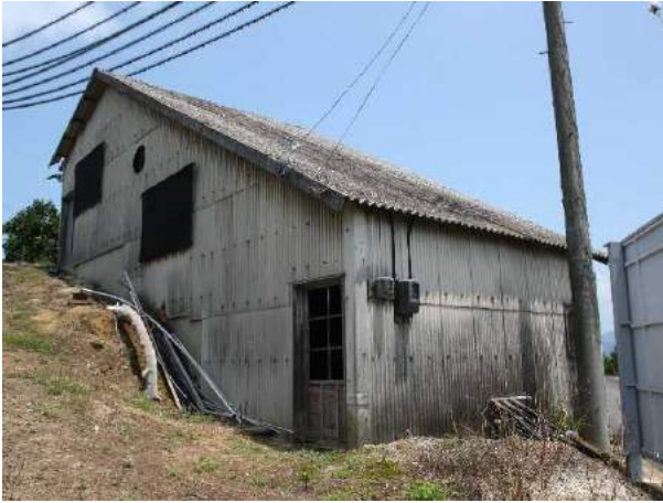
写真VI-3-1 共同利用施設を 設置した作業舎
