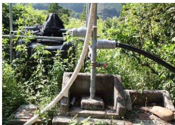
写真VI-1-7 N地区の取水口と 液肥混入システム
